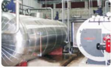
Yüksek Basıncılı Buhar Kazanı & Akümülayon Tankı
